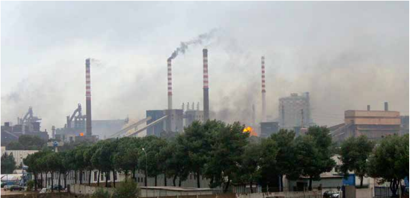
Le acciaierie ILVA: un contenzioso annoso volge al termine. Immagine: Keystone, LaPresse
